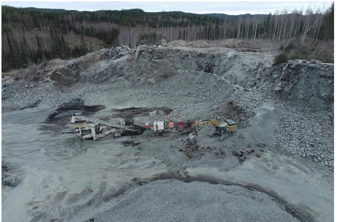
Kuva 3. Louhinta ja murskaus
